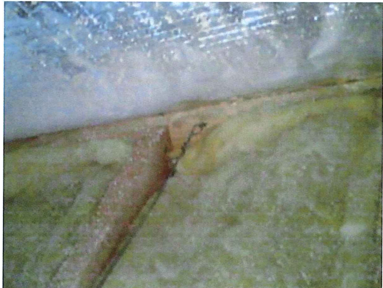
FLIR0904.jpg FLIR C2 720047737
